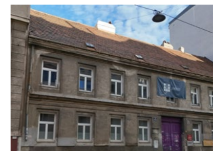
Bestandsgebäude vor der Sanierung
